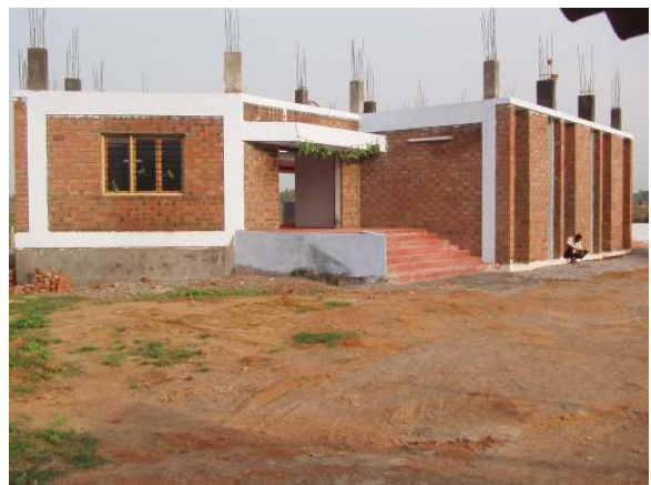
平成 19 年(2007 年)5 月 26 日 最後の工事が急ピッチで進む 生産・物流センター(於:スリカラム県パタパトナム)
